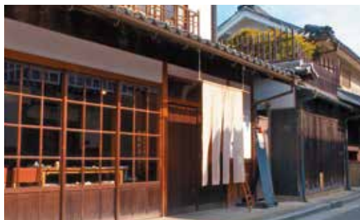
町家トラストが保全を手がけた町家（倉敷美観地区）
